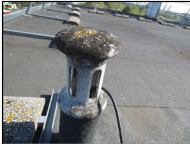
Photo N° 666 AMIANTE CIMENT -- Toiture terrasse Toiture Chapeau (Fibres-ciment)
